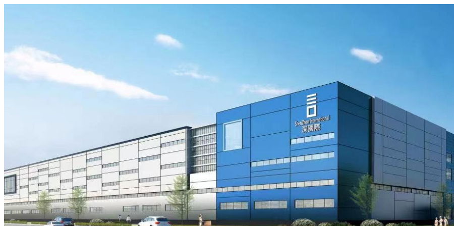
成都青白江冷库项目（已竣工投产）
